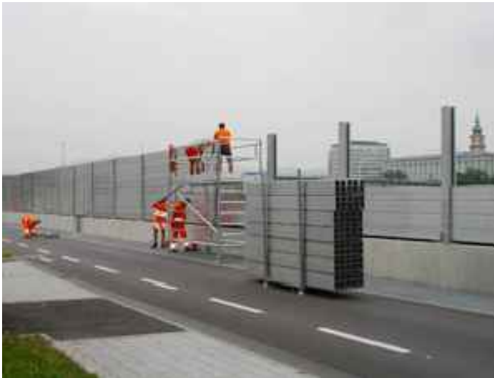
In previsione di evento straordinario: installazione di montanti e pannoni
